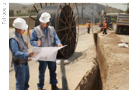
Se estima que en Lima, en los próximos 5 años, se alcanzarán dos millones de conexiones de GN.
